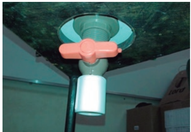
Figura 4 – Vista do fundo do tanque
